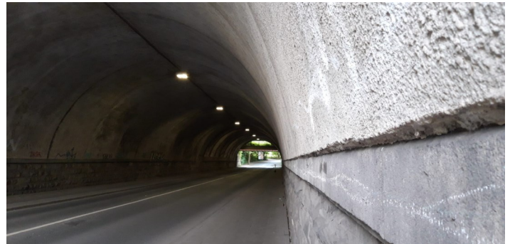
Das Bild zeigt den Tunnel Kohlenstraße.
